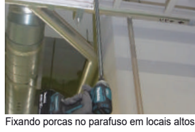
Fixando porcas no parafuso em locais altos
